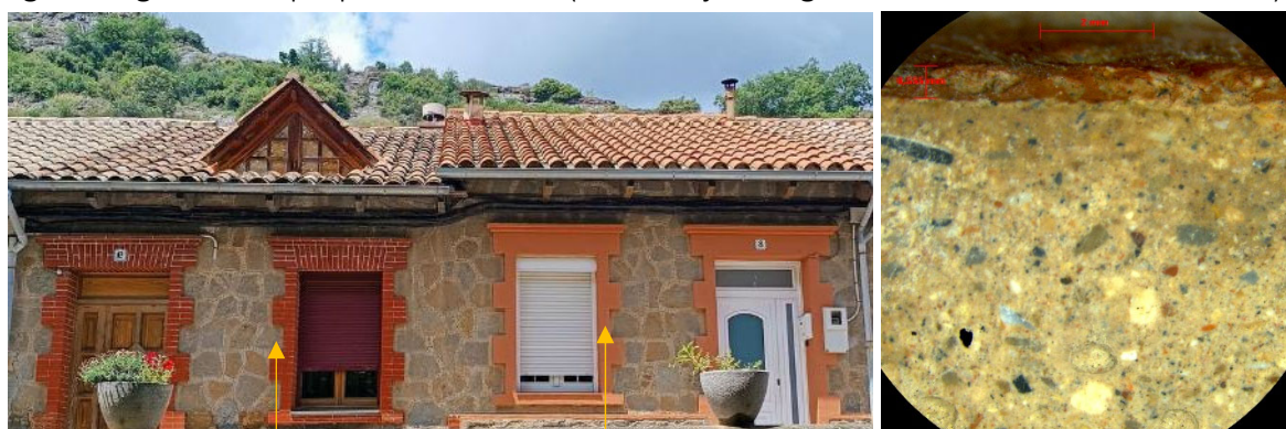
Emmarcament filetejat correctament i monocromatisme incorrecte. Micrografia de l'obra vista pintada.
