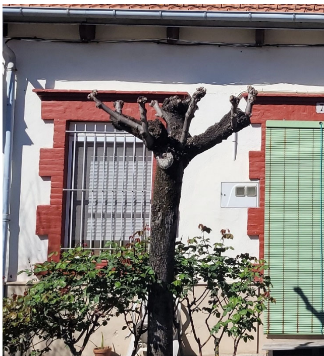
Reixa de barrots verticals, sense "floritures". Solució recomanable i única acceptable.
