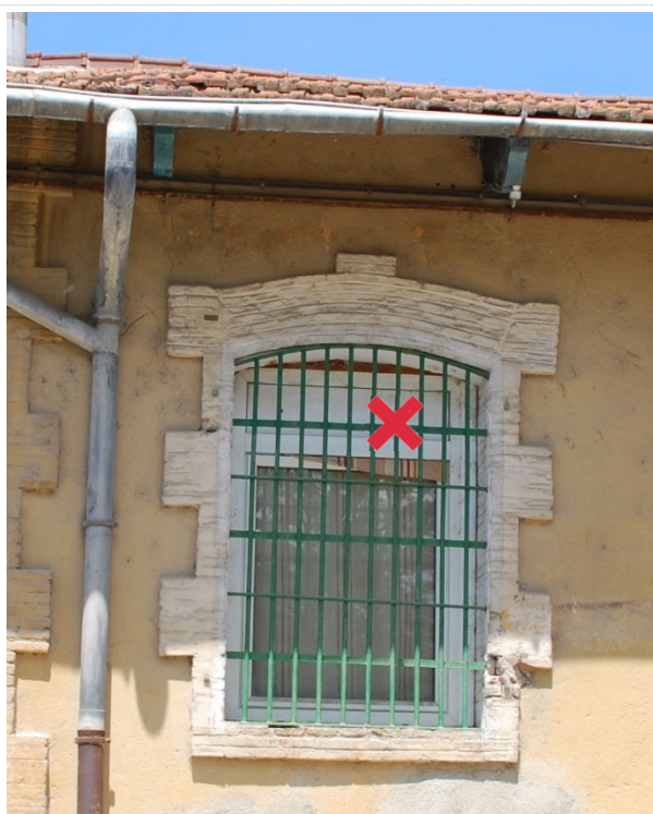
Solució de reixa molt acceptable, tot i que sobra únicament la quantitat d'elements horitzontals.
