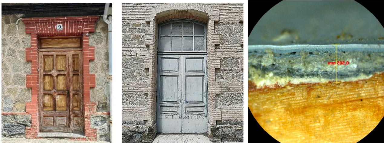
Exemples de fusteries tant de l'edificació industrial com residencial i la seva estratigrafia blava.
