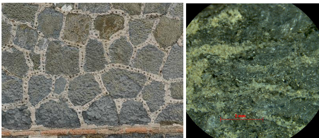
Detall de la mamposteria encintada i morfologia de la pedra fosca local.
