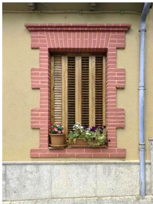
Emmarcament filetejat i fusteria envernissada.
