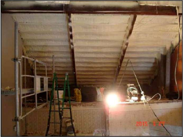
6 - Estructura coberta de la façana posterior
