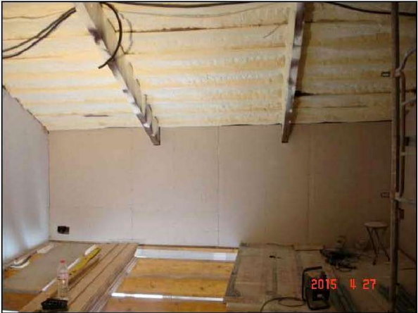
5 - Estructura coberta de la façana principal
