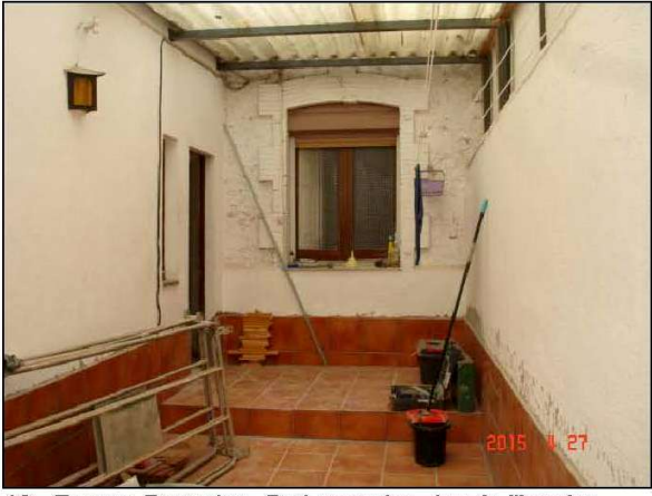
16 - Façana Posterior - Pati posterior, des de l'interior
