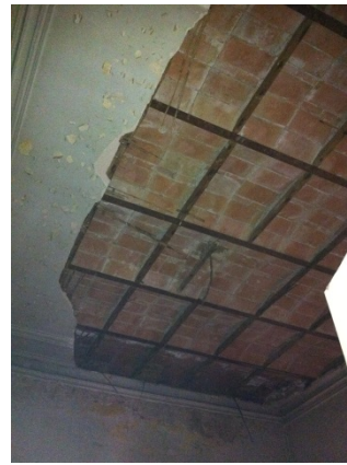
Trespol bigueta acer i volta ceràmica de la casa del metge. Font Arquitectura Genís Planelles slp
