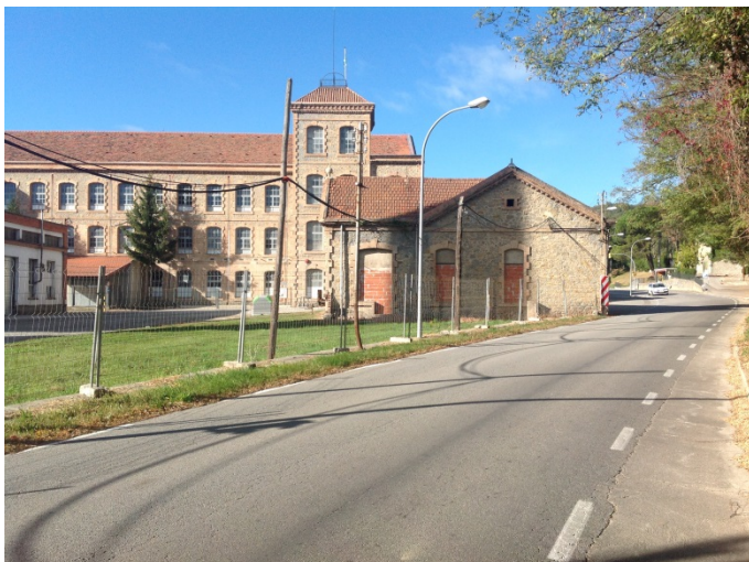
Imatge 4. Vista exterior dels Xalets 6 i 7 de la façana Est- cantonada carretera.
